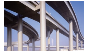
高速道路橋脚
