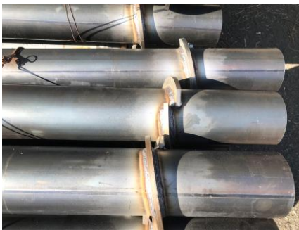
鋼管への羽根付け
