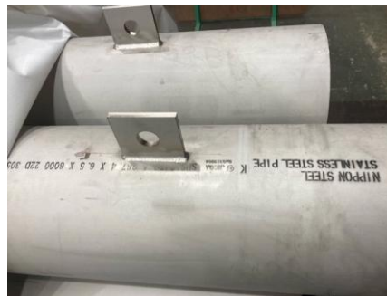
吊り金具溶接 (ステンレス)
