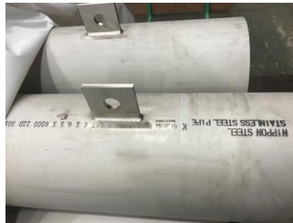
吊り金具溶接（ステンレス）
