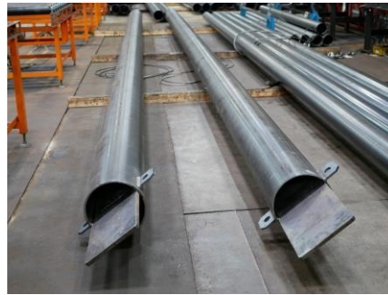
吊り金具、チャッキングプレート溶接
