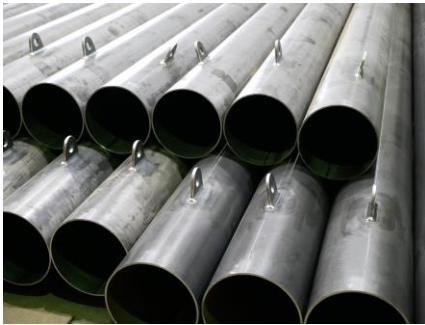
吊り金具溶接
