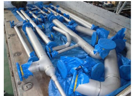
各種配管加工
