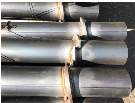
鋼管への羽根付け
